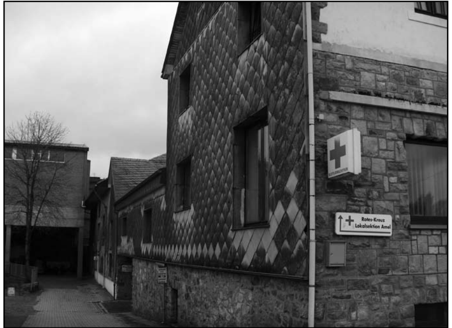
Der alte Molkereikomplex wird isoliert.
