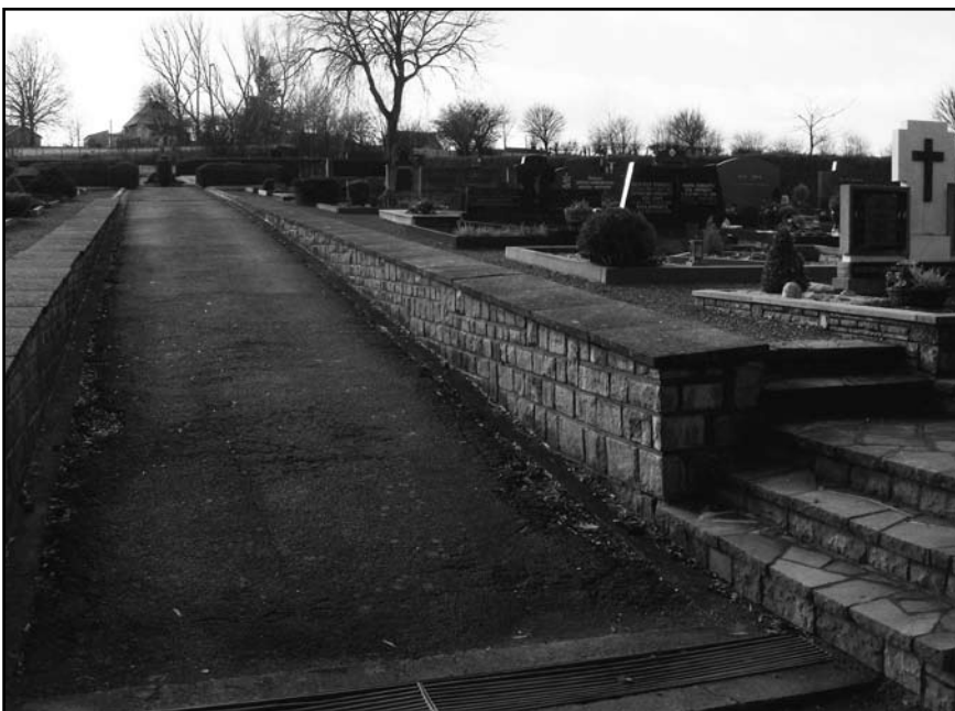
Die Gehwege des Friedhofes in Deidenberg werden in der zweiten Jahreshälfte erneuert.
