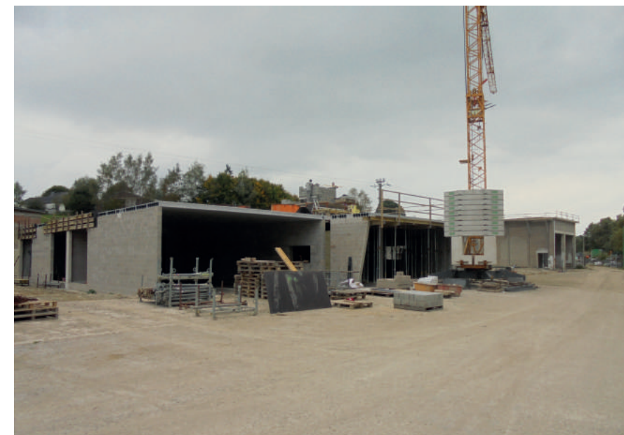
Die Arbeiten am neuen Bauhof in Amel
