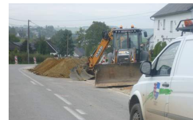
Die Büllinger Straße wird grundlegend erneuert.
