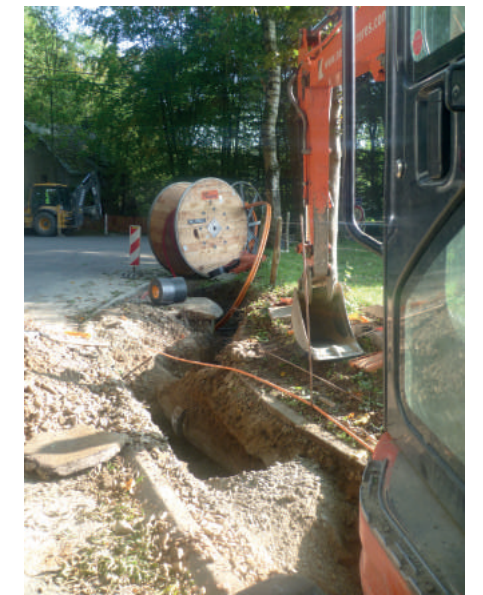
Kabelverlegungsarbeiten werden aktuell in Schoppen durchgeführt.
